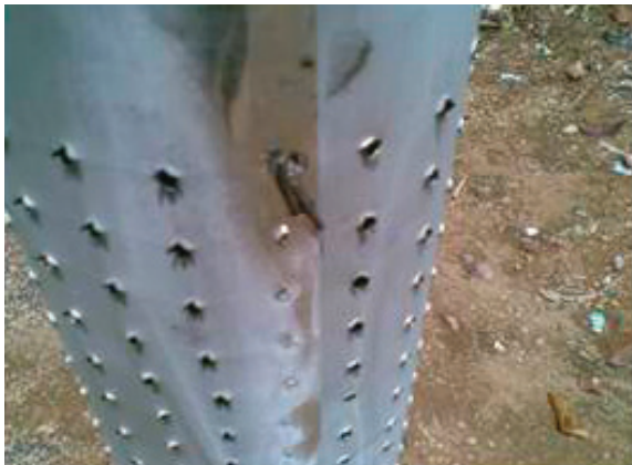
Gambar 2. Cerobong Pembakaran Arang Sekam Padi
