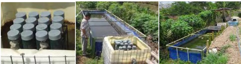
**Gambar 3. Pemasangan biofilter (kiri) sebagai penjernih air limbah (tengah) digester biogas pada kolam ikan gurameh (kanan)**
