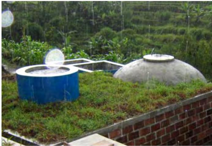
**Gambar 4. Biogas di KP Bandongan, tipe fixed dome dengan kapasitas 9 M<sup>3</sup>**
