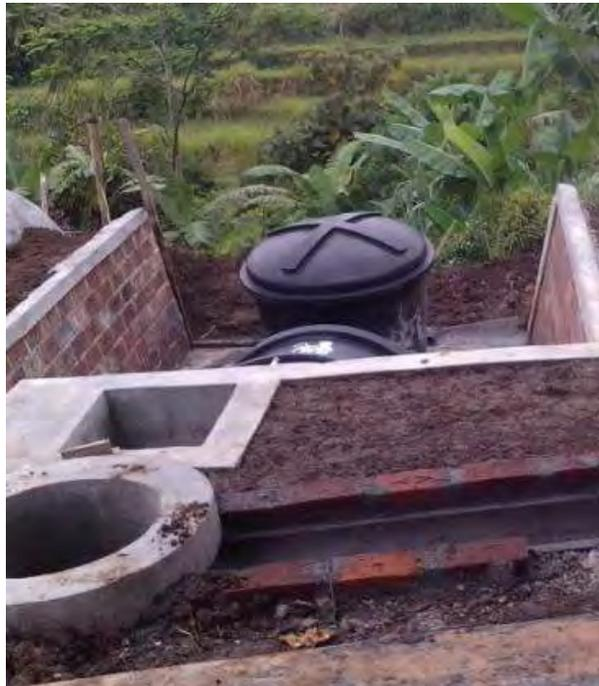
**Gambar 8. Letak instalasi biogas portabel kapasitas 5,3 M<sup>3</sup> di KP Bandongan**
