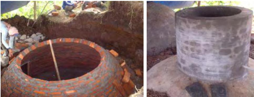
**Gambar 1. Digester dilengkapi dengan penutup**
