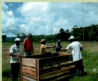
Siapkan cetakan kayu/bambu, ukuran  $p \times l \times t = 2m \times 1m \times 1m$
