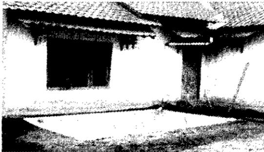
**Gambar 4.** Embung melalui tangkapan air rumah tangga
