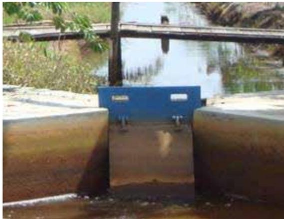
Gambar 24. Pintu air (*flapgate*) semi otomatis
