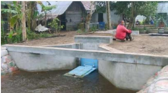
Gambar 7. Sistem pintu air makro di saluran primer yang masuk menuju saluran sekunder area lahan budidaya
