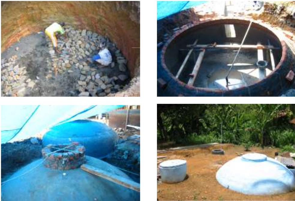
Gambar 2. Disain reaktor biogas tipe *fixed dome*
