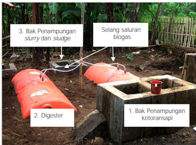
Gambar 34. Unit instalasi pemrosesan kotoran sapi menjadi energi biogas
