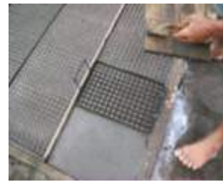
(c) cetakan besi yang siap dilubangi dengan papan kayu
