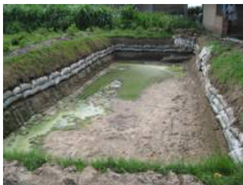
Kolam tanah dengan penguat dinding berupa karung berisi pasir/tanah
