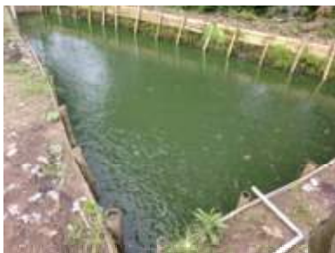
Kolam tanah dengan penguat dinding berupa batang bambu
