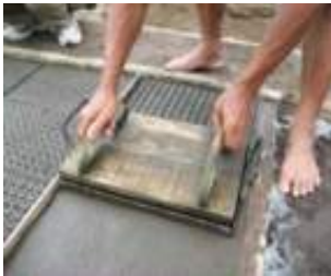
(d) papan dilengkapi pelubang kayu sebagai pelubang
