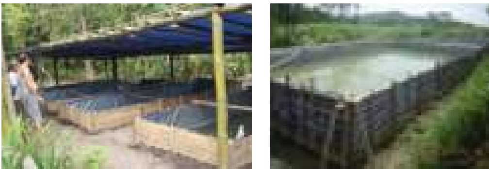
Gambar 5. Kolam Terpal dengan Rangka Dinding Terbuat dari Anyaman Bambu (kiri) dan Batang Bambu (kanan)
