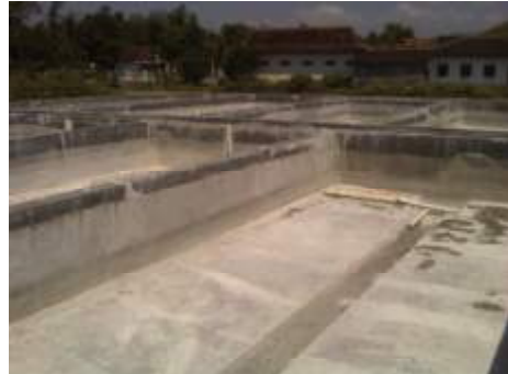
Dasar kolam semen membentuk huruf V mempermudah panen dan pembersihan
