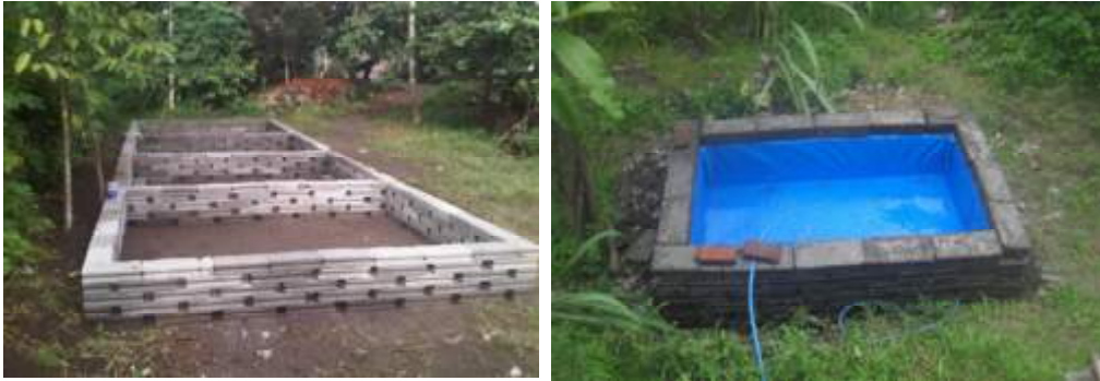
Gambar 6. Penyusunan Batako untuk Dinding Kolam Terpal (kiri) dan Kolam Terpal Berdinding Tumpukan Batako (kanan)
