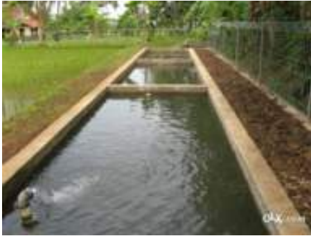
Kolam semen menggunakan pipa pralon sebagai saluran pemasukan air
