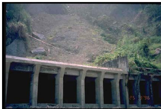
Gambar 7. Bangunan konstruksi beton penahan longsor kategori besar. (Foto: F. Agus dan Widiyanto)
