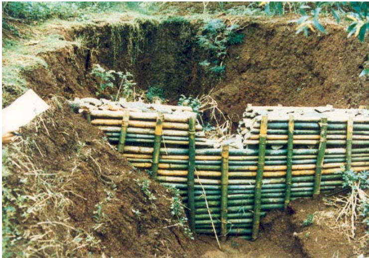
Gambar 6. Bangunan penahan longsor dari anyaman bambu untuk menahan longsor kategori kecil. (Foto: Widiyanto)
