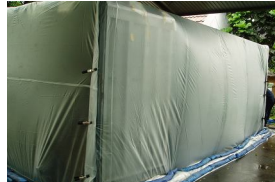
Gambar 2. Pemasangan lembar penutup
