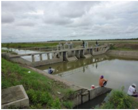
Gambar 7. Pintu air di rawa Sragi (Lampung) IP 200 Figure 7. Water gate in tidal Sragi (Lampung) IP 200
