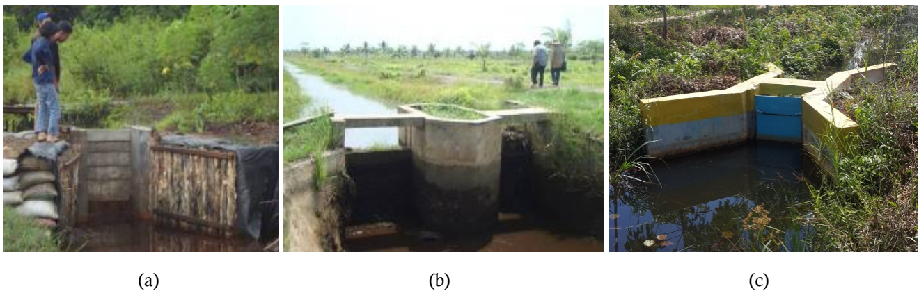
Gambar 5. Model tabat dari kayu (a), beton (b), dan flap gate (c)
