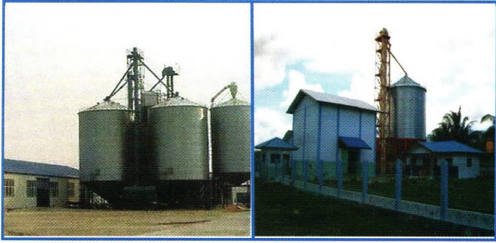
Gambar 15. Penyimpanan gabah dengan sistem curah
