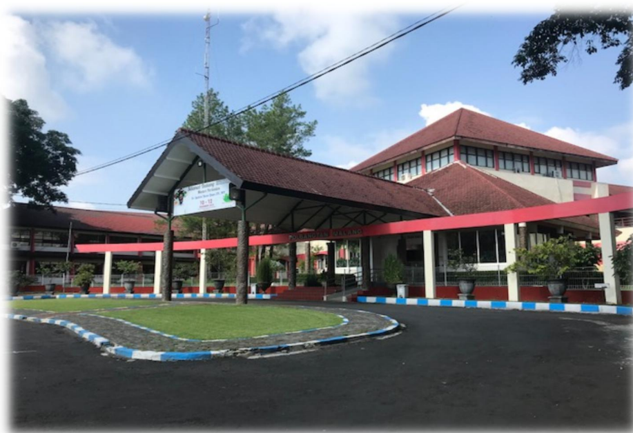
Gambar 1. Gedung Utaman Polbangtan Malang
